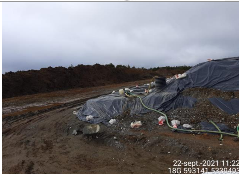
Fotografía N°6: Extracción de Lixiviados desde diagonales C10 por Personal Municipal. Tomada: Miércoles 22 de Septiembre del 2021
